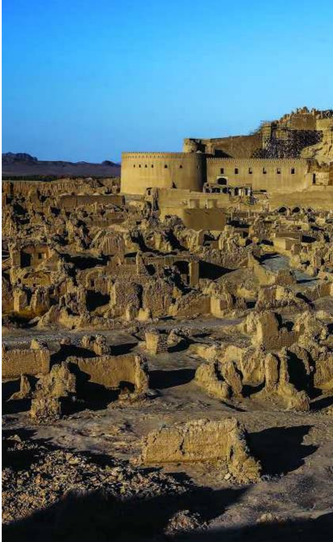
ارگ یم بعد از زلزله
